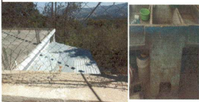
Foto1: Muro perimetral y pileta
