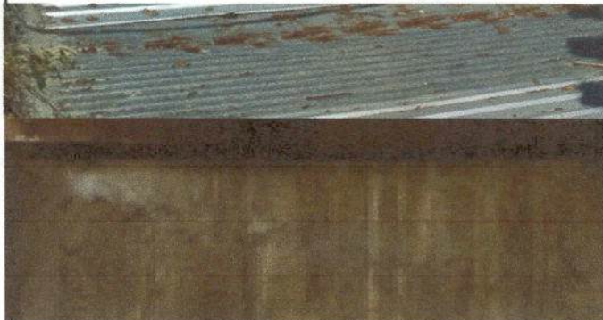
Foto 2: Techo y muro de contención
